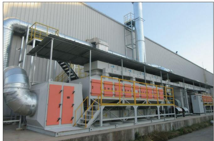
寮步工厂(一、二厂区) 升级印刷废气收集净化设施
